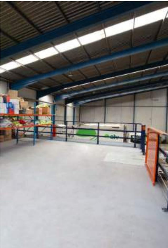
Estas estructuras están compuestas por pilares conectados entre sí mediante vigas de carga y largueros que constituyen una estructura fuerte y robusta. Se puede instalar como extensión de un altillo existente.
