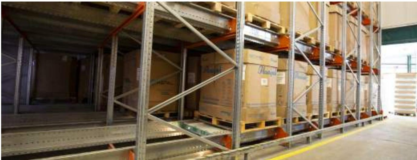
Esta solución semiautomática mediante dispositivo **TS Shuttle** diseñada por **TECNY STAND** le permite introducir los palets en el interior de las estanterías sin necesidad de que las carretillas elevadoras tengan que acceder al interior de estas. Con esto se minimizan los daños en la estructura y los riesgos de accidentes.
