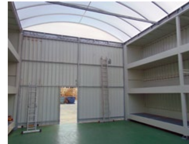
Interior almacén con puerta anti-pánico
