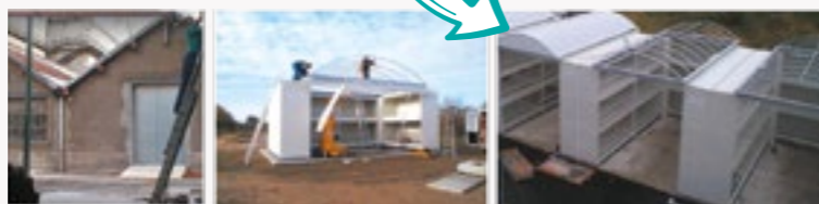
Montaje de techos y puertas.
