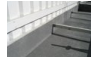
Revestimiento de resina en cubeto de retención
