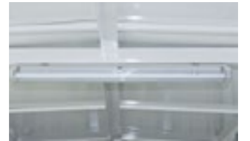
Iluminación interior ATEX
