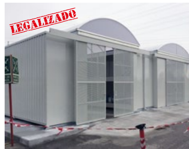
2 almacenes unidos de 8 x 7,5 m, puertas de rejilla
