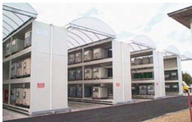
210 posiciones de almacenamiento
