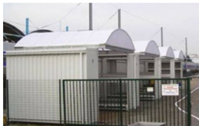
190 posiciones de almacenamiento
