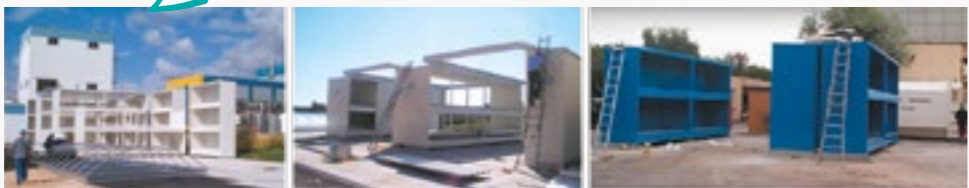
Posicionamiento de los contenedores y montaje de la estructura de los techos.
